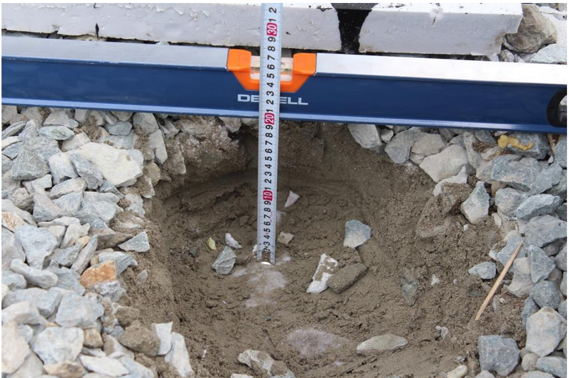
Фото №2 – Вскрытие щебеночной подушки №1. Толщина 200 мм.
