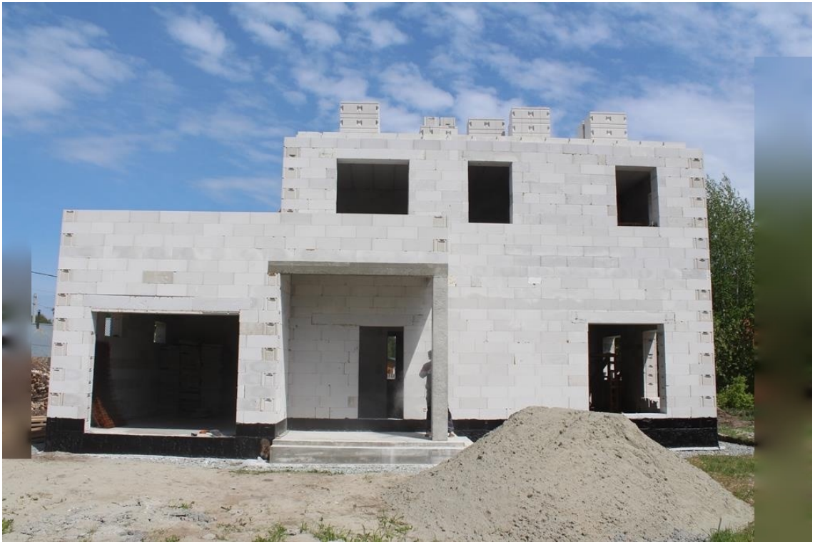
Фото №1 – Общий вид здания по оси А
