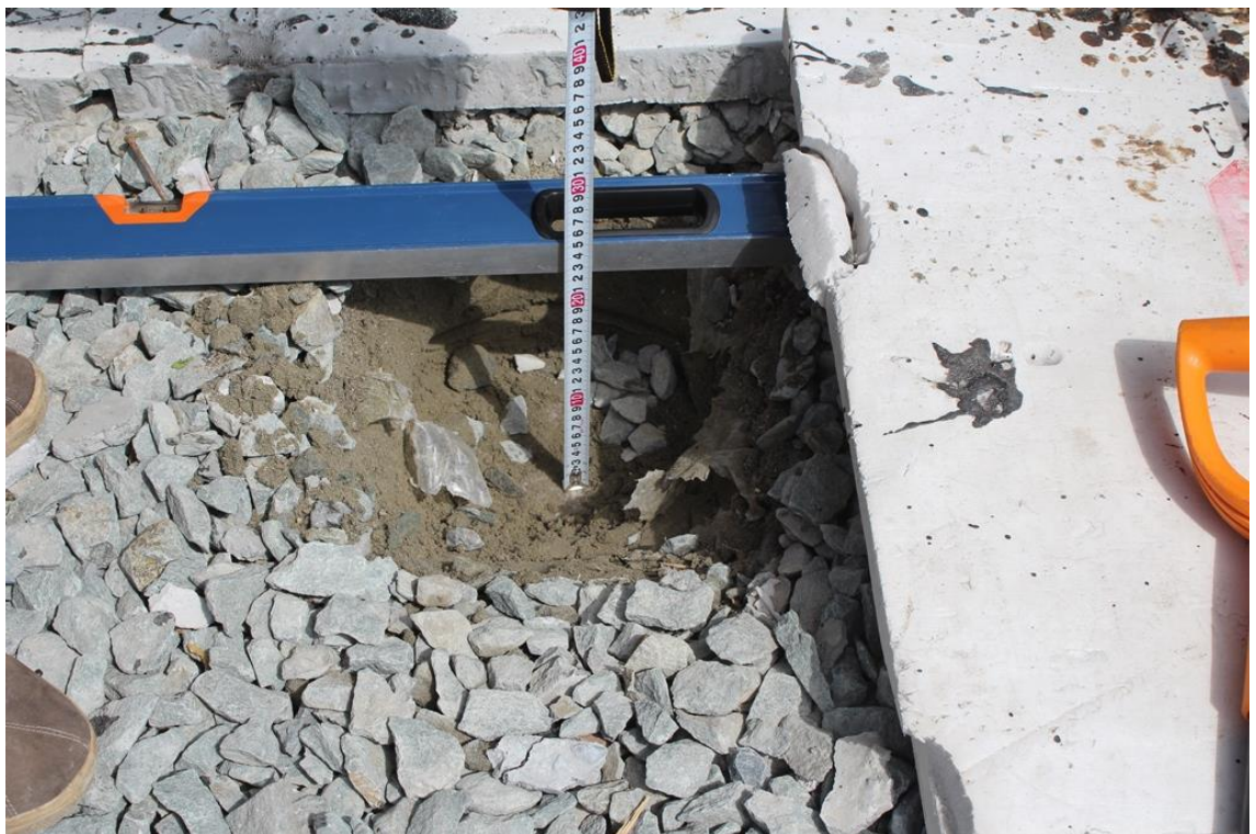
Фото №4 – Вскрытие щебеночной подушки №3. Толщина 230 мм.
