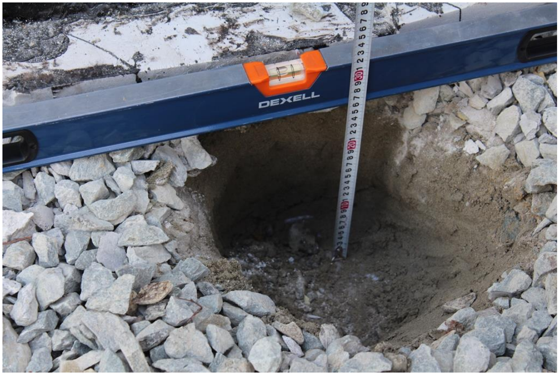
Фото №3 – Вскрытие щебеночной подушки №2. Толщина 265 мм.
